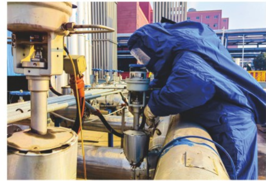
▲恒腾公司演练现场工作人员正在抢修
